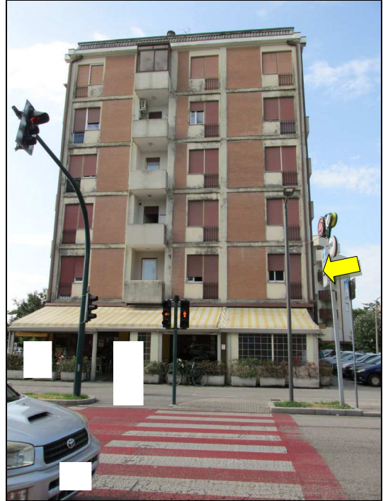
Fig.2: vista nord palazzina
