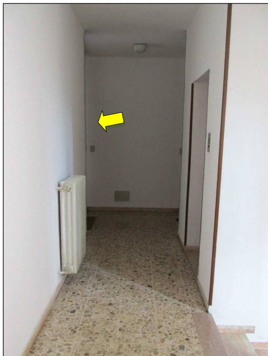
Fig.10: disimpegno comune piano primo
