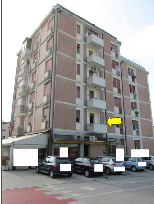
Fig.1: vista nord - ovest palazzina
