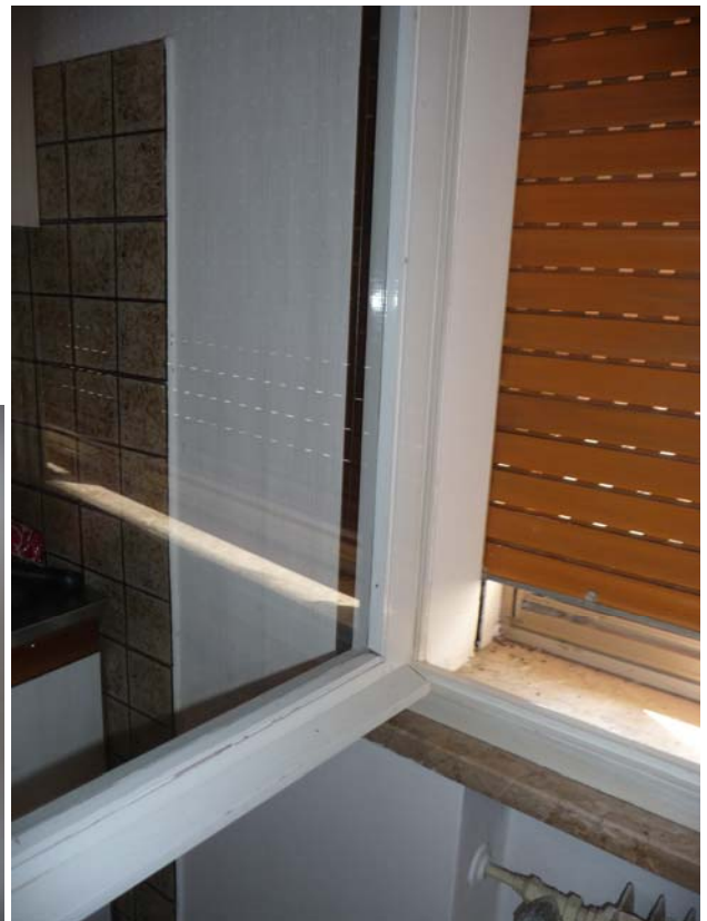
particolare serramento interno
