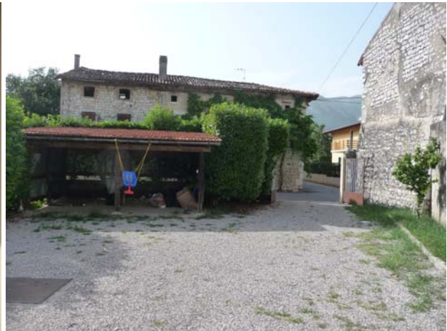
veduta tettoia - ingresso lotto
