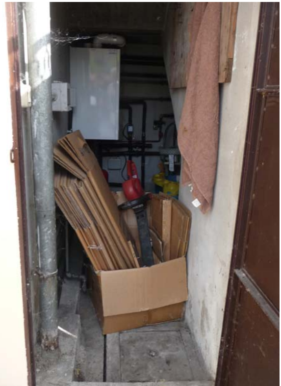
locale c.t. sottoscala
