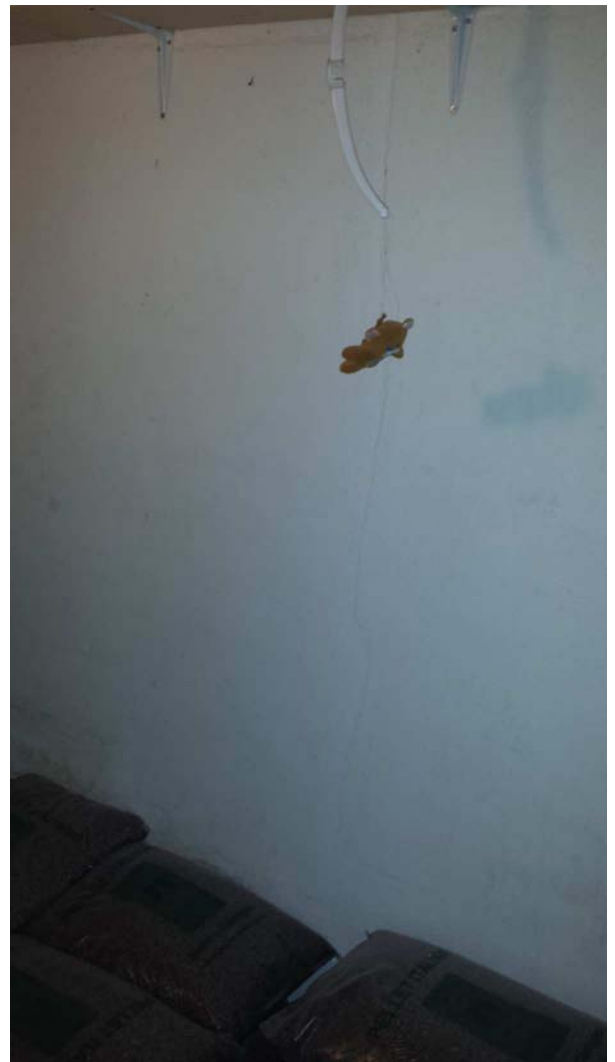
Foto n. 8 – ripostiglio piano seminterrato
