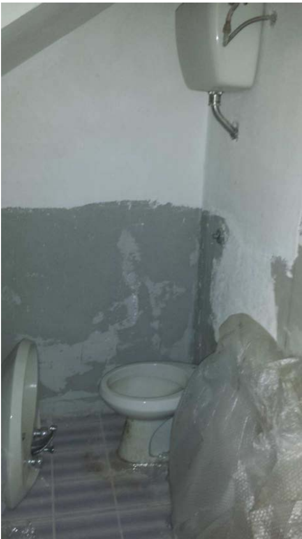
Foto n. 7 – bagno piano seminterrato
