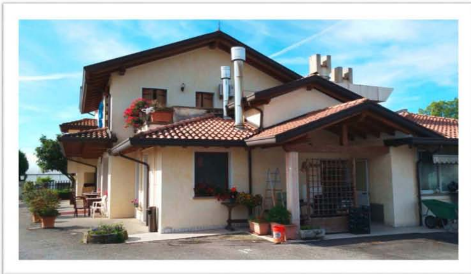
FABBRICATO PROSPETTO LATERALE
