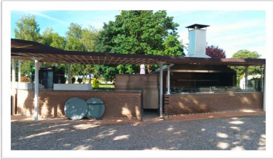
AREA ESTERNA TETTOIA BARBECUE
