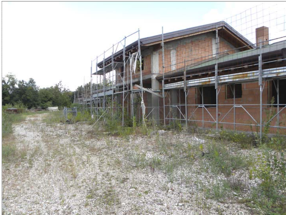
Zugliano di Pozzuolo del Friuli (UD): attrezzature di cantiere (impalcature)
