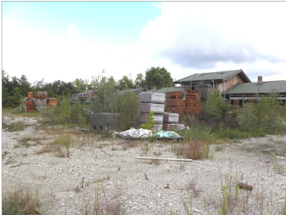
Zugliano di Pozzuolo del Friuli (UD): area scoperta di cantiere
