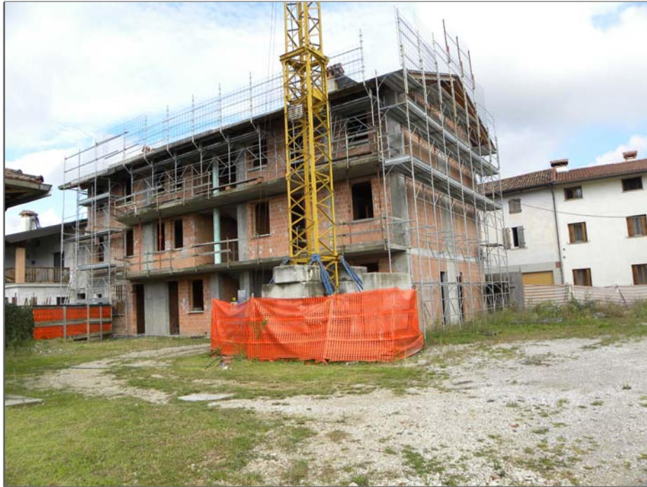
San Giorgio della Richinvelda (PN): parte costruita - retro (da Sud-Est)
