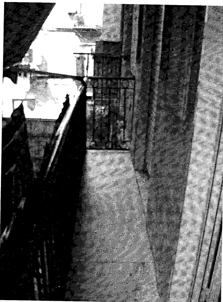
Foto 23 Balcone sulla strada interna (apertura lato Sud)
