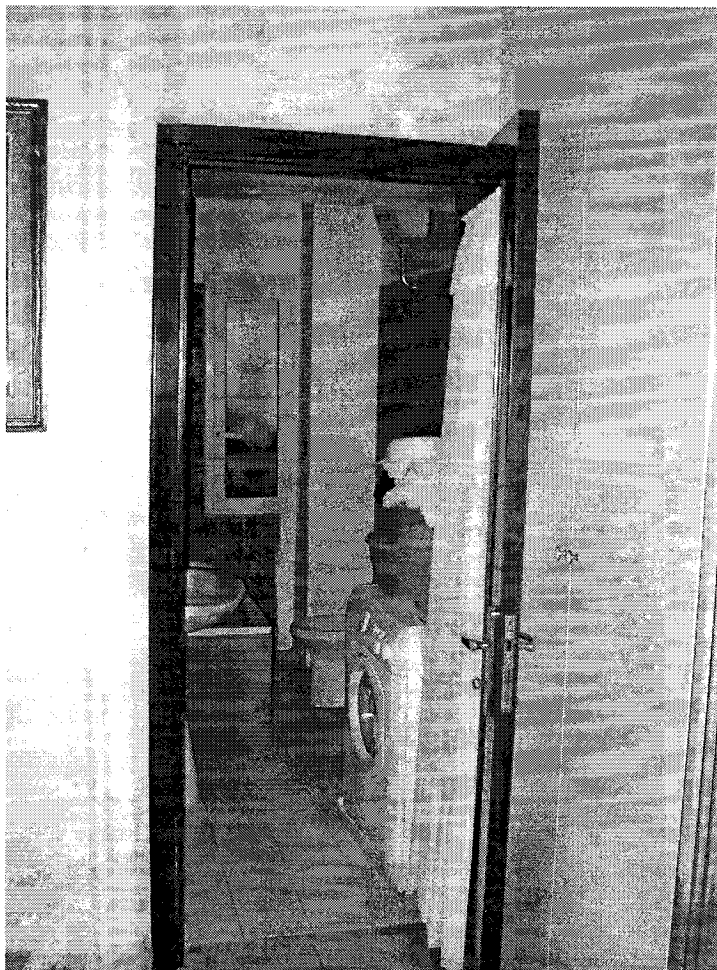
Foto 16 Bagno (apertura lato Sud)
