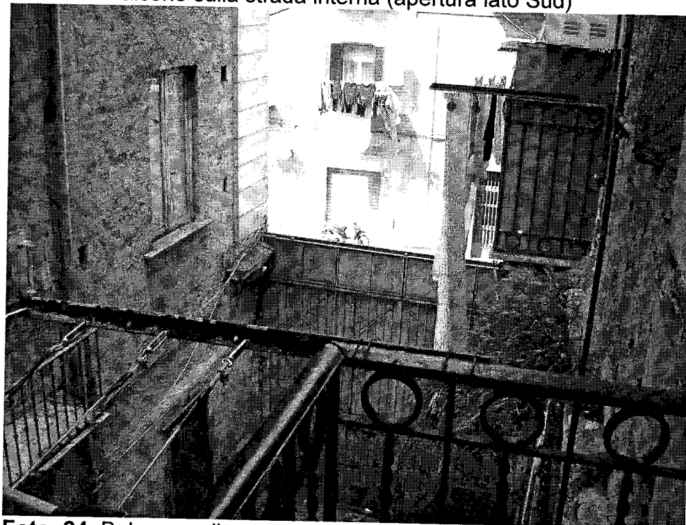
Foto 24 Balcone sulla strada interna (apertura lato Sud)
