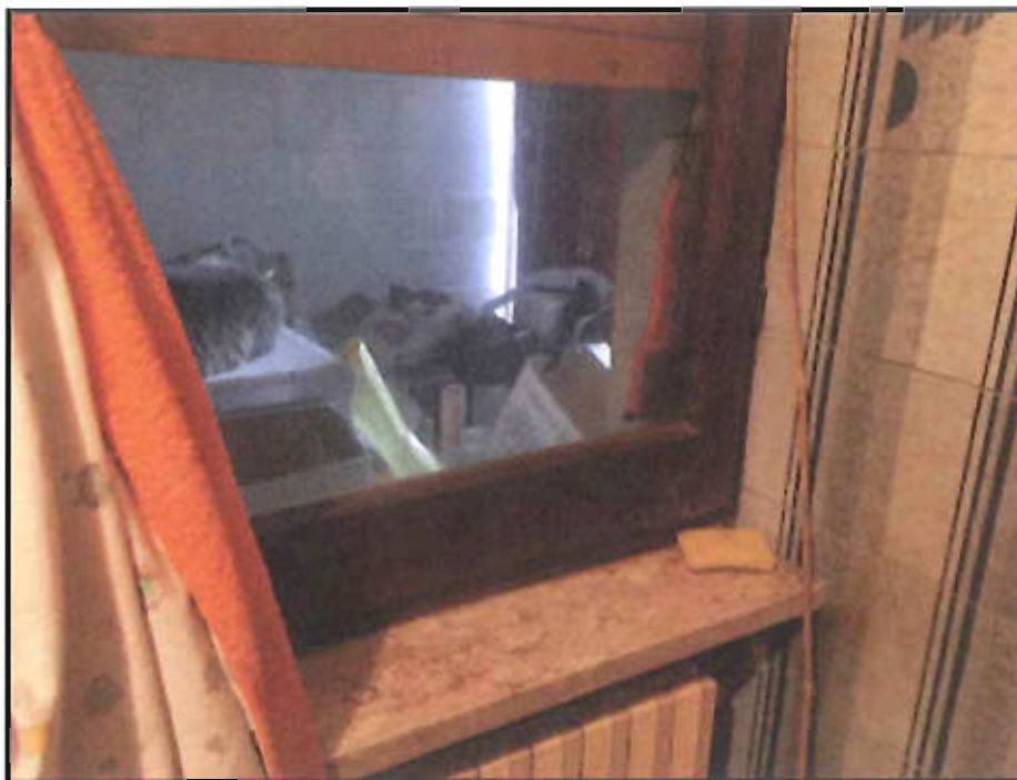
Figura 24: bagno lato EST
