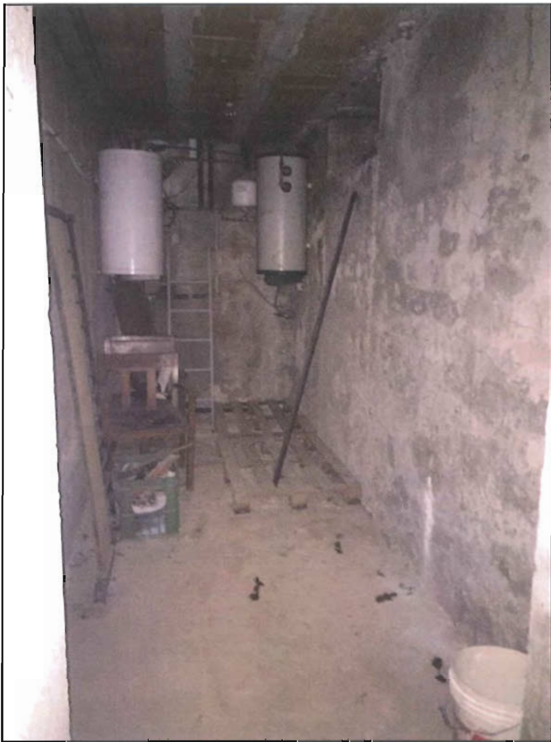
Figura 49: ripostiglio piano S1
