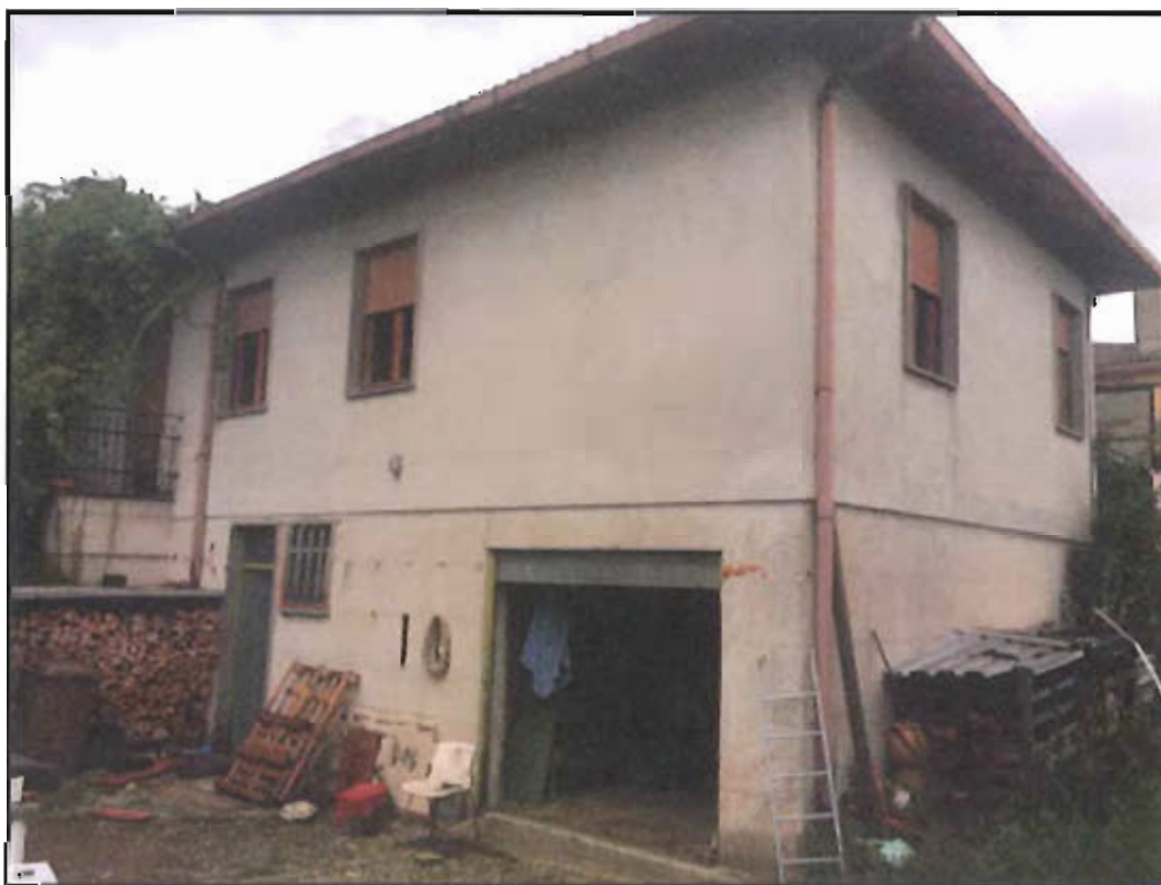
Figura 5: particolare fabbricato lato SUD-OVEST
