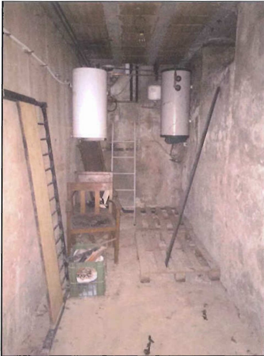
Figura 50: ripostiglio piano S1
