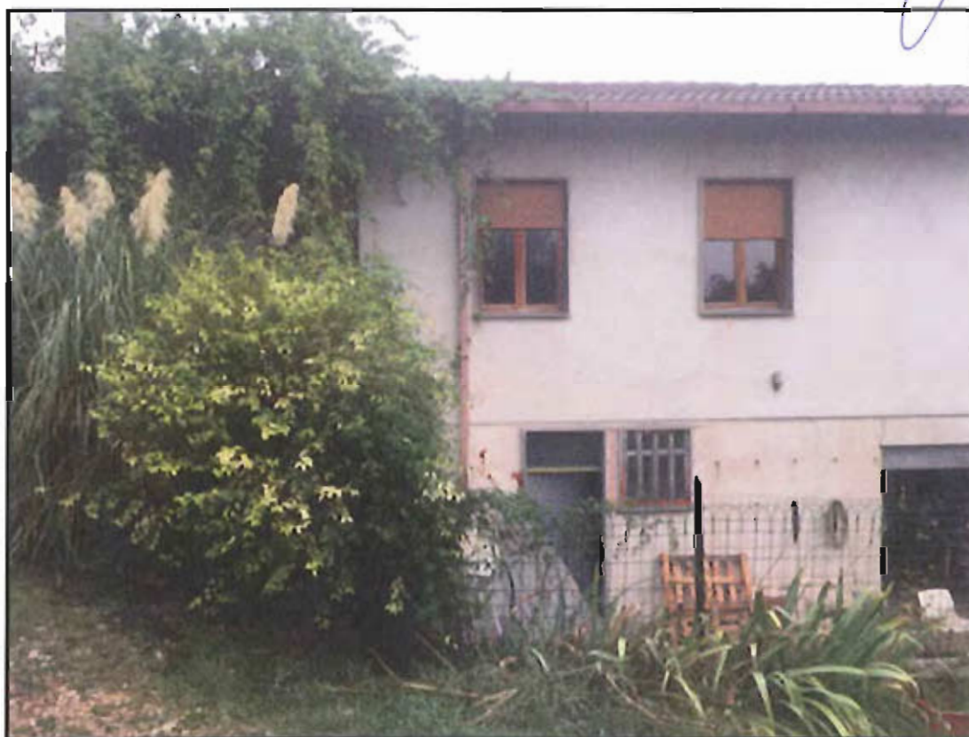
Figura 3 : Particolare lato Ovest del fabbricato.
