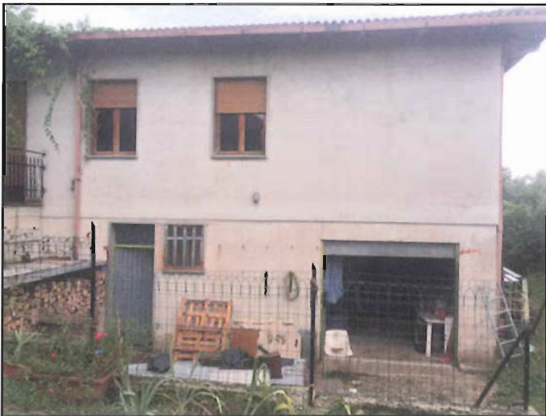
Figura 4: particolare lato OVEST del fabbricato
