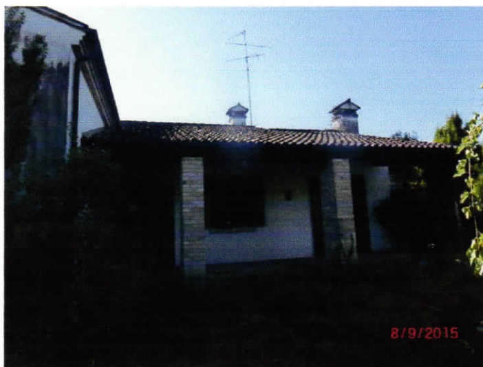
prospetto Nord-Ovest del fabbricato
