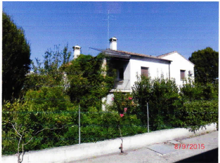
prospetto Sud-Ovest del fabbricato
