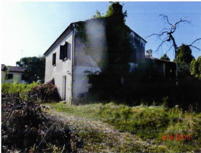
prospetto Nord-Est del fabbricato
