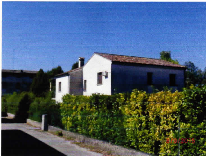
prospetto Sud-Est del fabbricato
