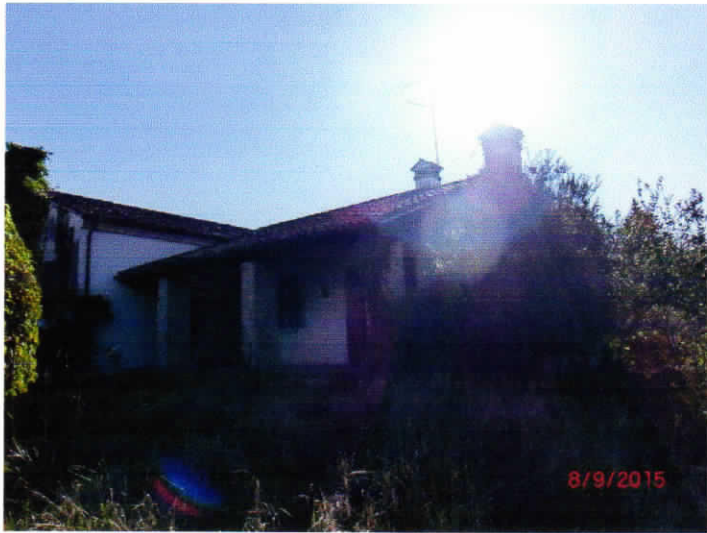
prospetto Nord-Ovest del fabbricato
