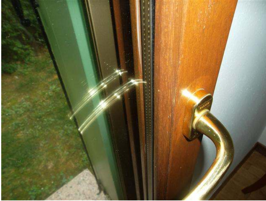
Foto n. 7: Particolare Serramento (vetro doppio camera).
