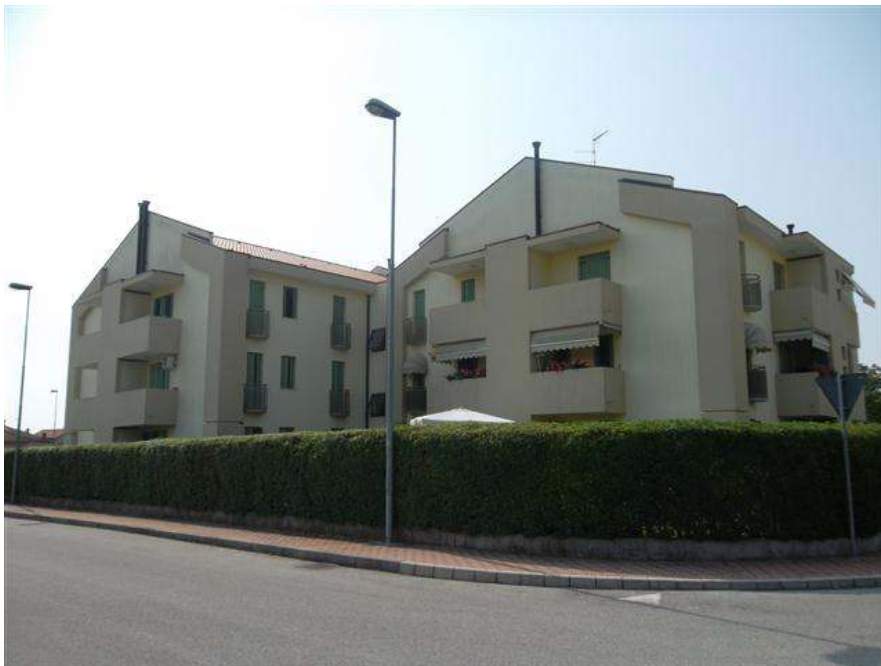
Foto n. 18: Panoramica Condominio su Fronte Strada.
