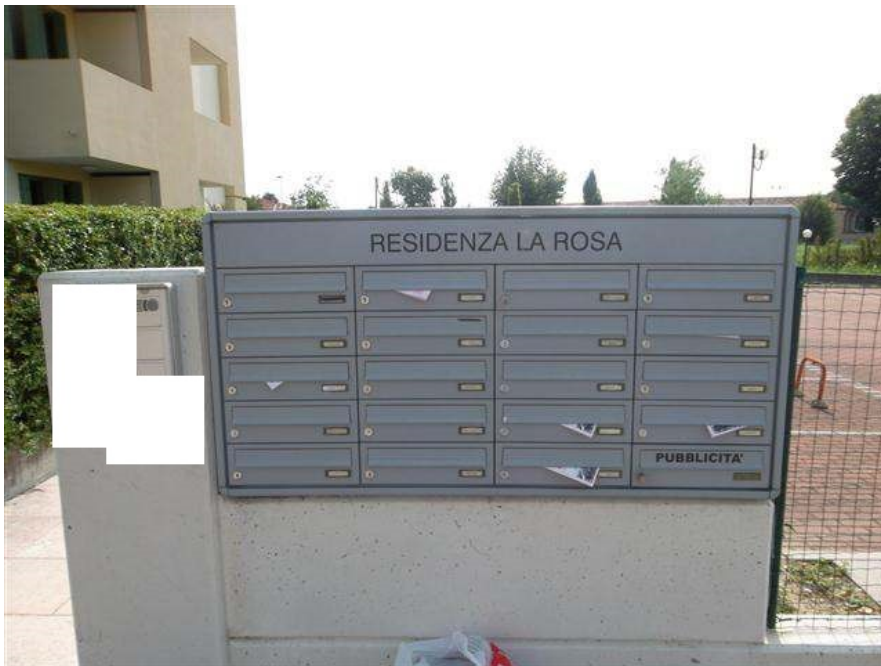
Foto n. 16: Panoramica su Accesso.
