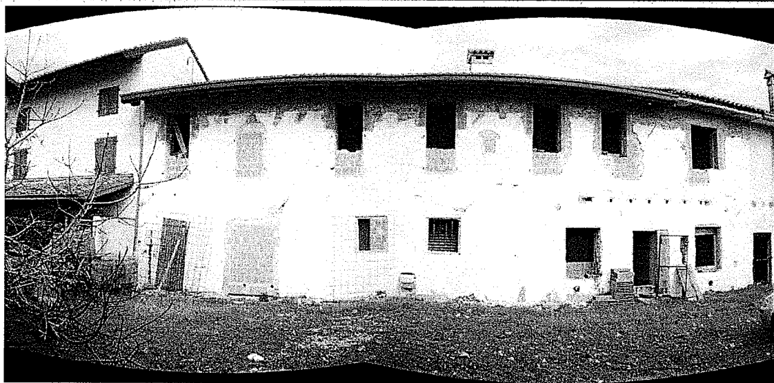
FRONTE CASA IN FASE DI RISTRUTTURAZIONE
