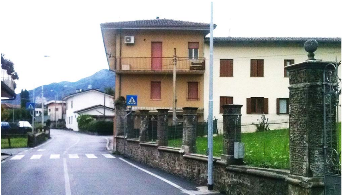
Foto 1. Prospetto lato ingresso
