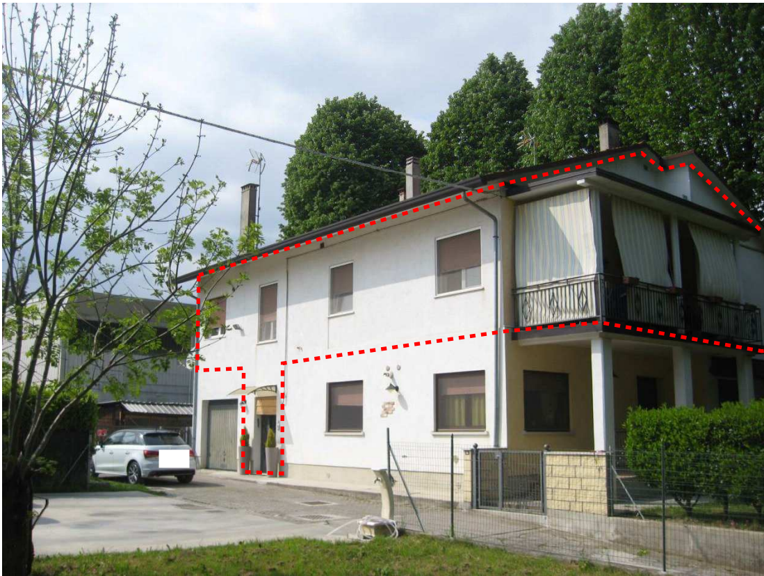
Vista fronte sud ed est
