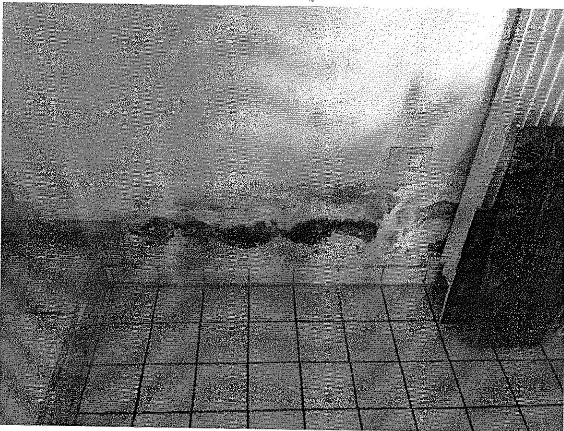
Figura 6 particolare muro ad ovest
