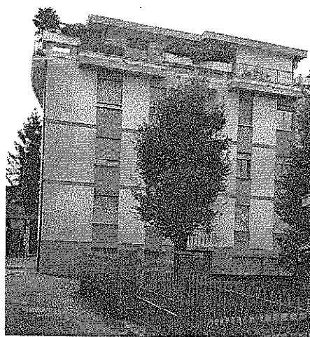
Facciata lato Nord
