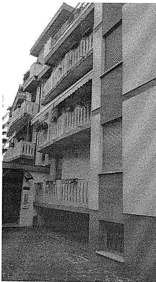
Facciata EST – Lato ingresso
