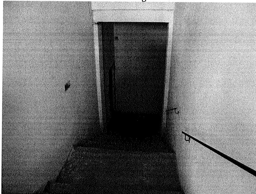
Scala di accesso condominiale al magazzino
