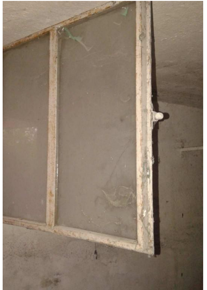
particolare serramento autorimessa
