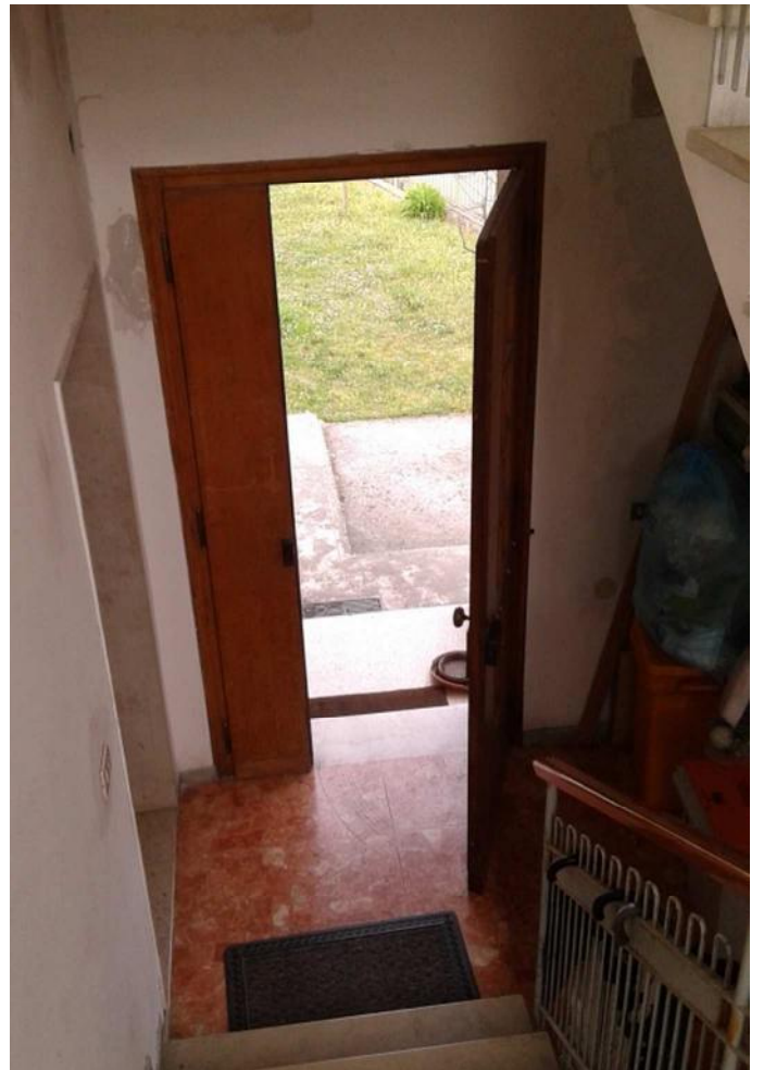
vano scala condominiale
