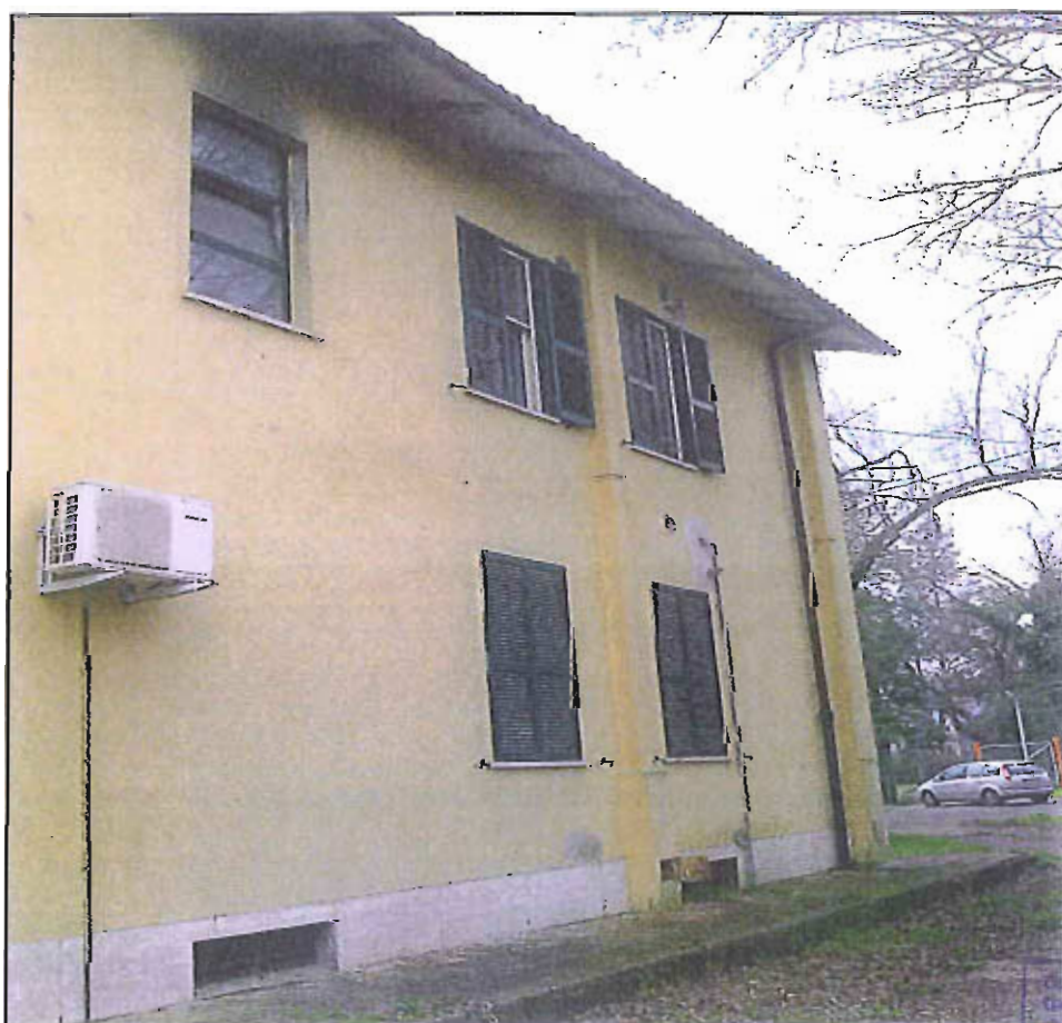
Figura 6 : Particolare lato Nord dell'appartamento.
