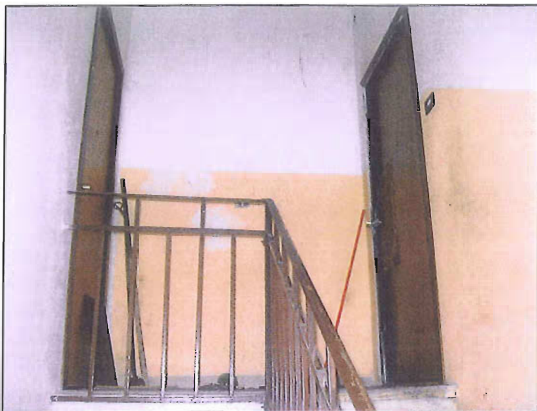
Figura 9 : Particolare d'accesso all'appartamento al piano primo.
