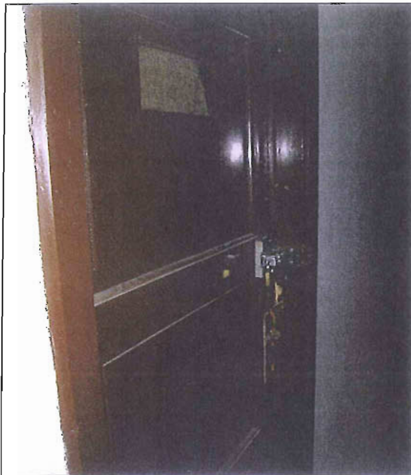
Figura 25 : Particolare della porta in legno della cantina.
