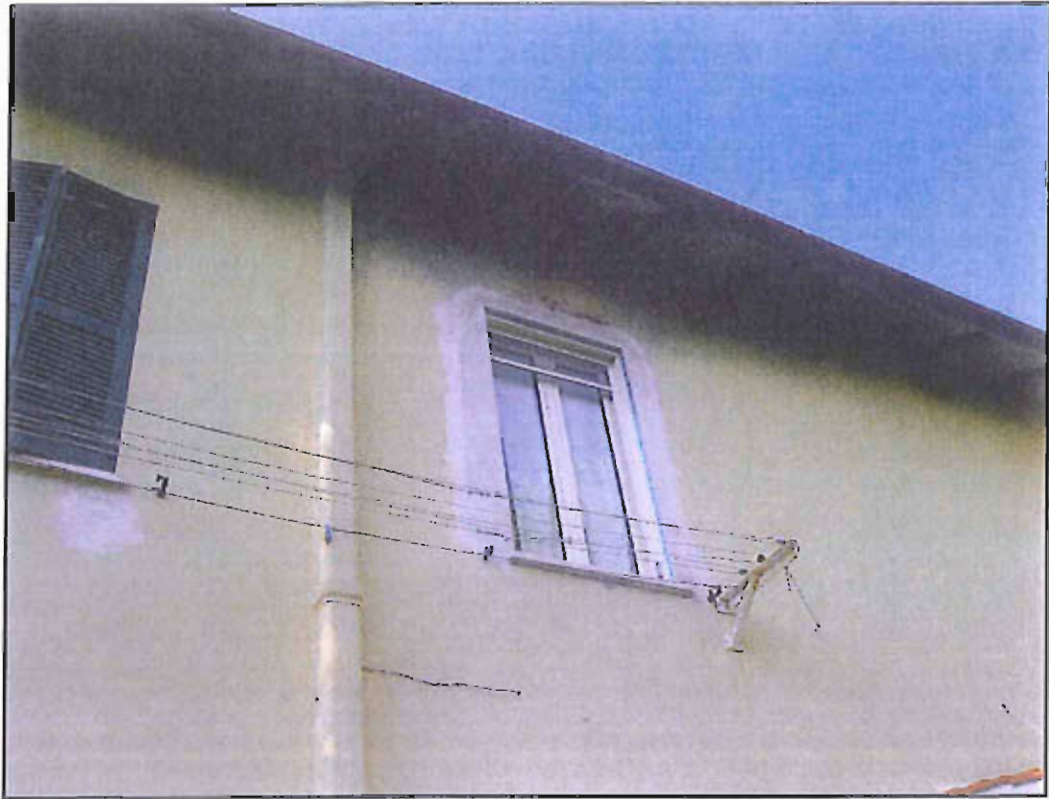
Figura 3 : Particolare della finestra del soggiorno dell'appartamento lato sud.
