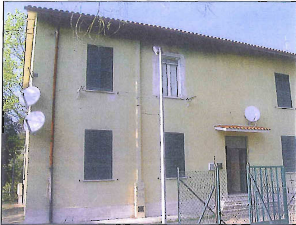
Figura 1 : Particolare dell'ingresso all'appartamento al piano primo del fabbricato.
