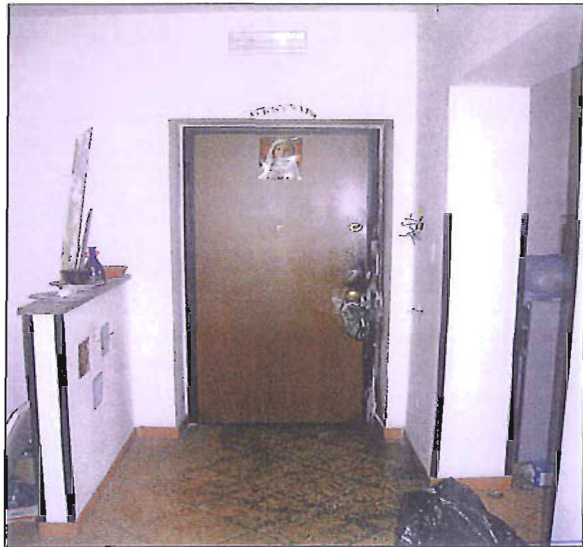
Figura 7 : Particolare ingresso e corridoio.
