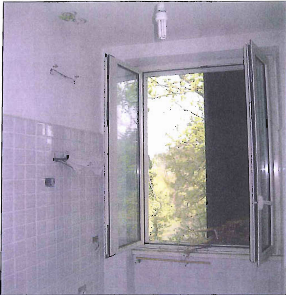
Figura 13 : Particolare finestra del bagno.
