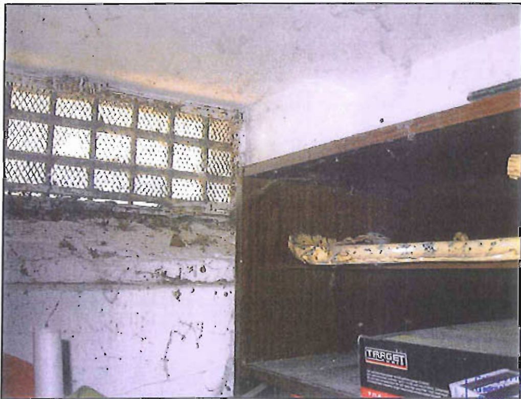
Figura 28 : Particolare della finestra in ferro e rete della cantina.
