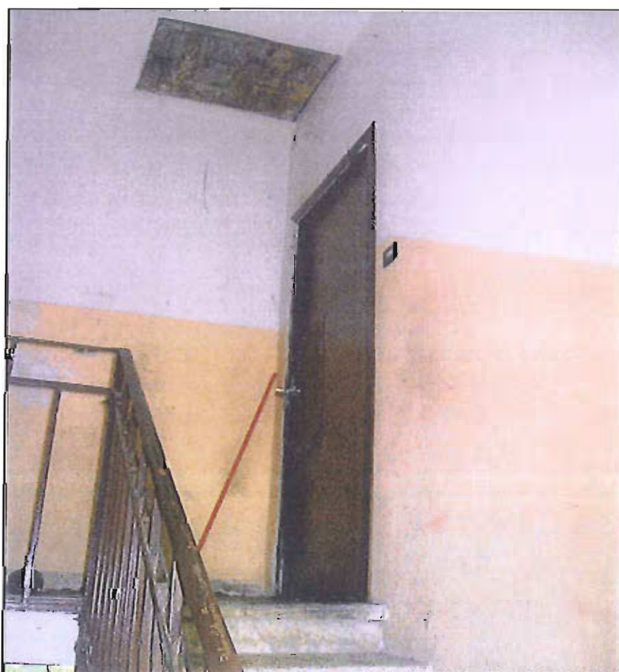
Figura 8 : Particolare dell'ingresso dell'appartamento al piano primo tramite vano scala.
