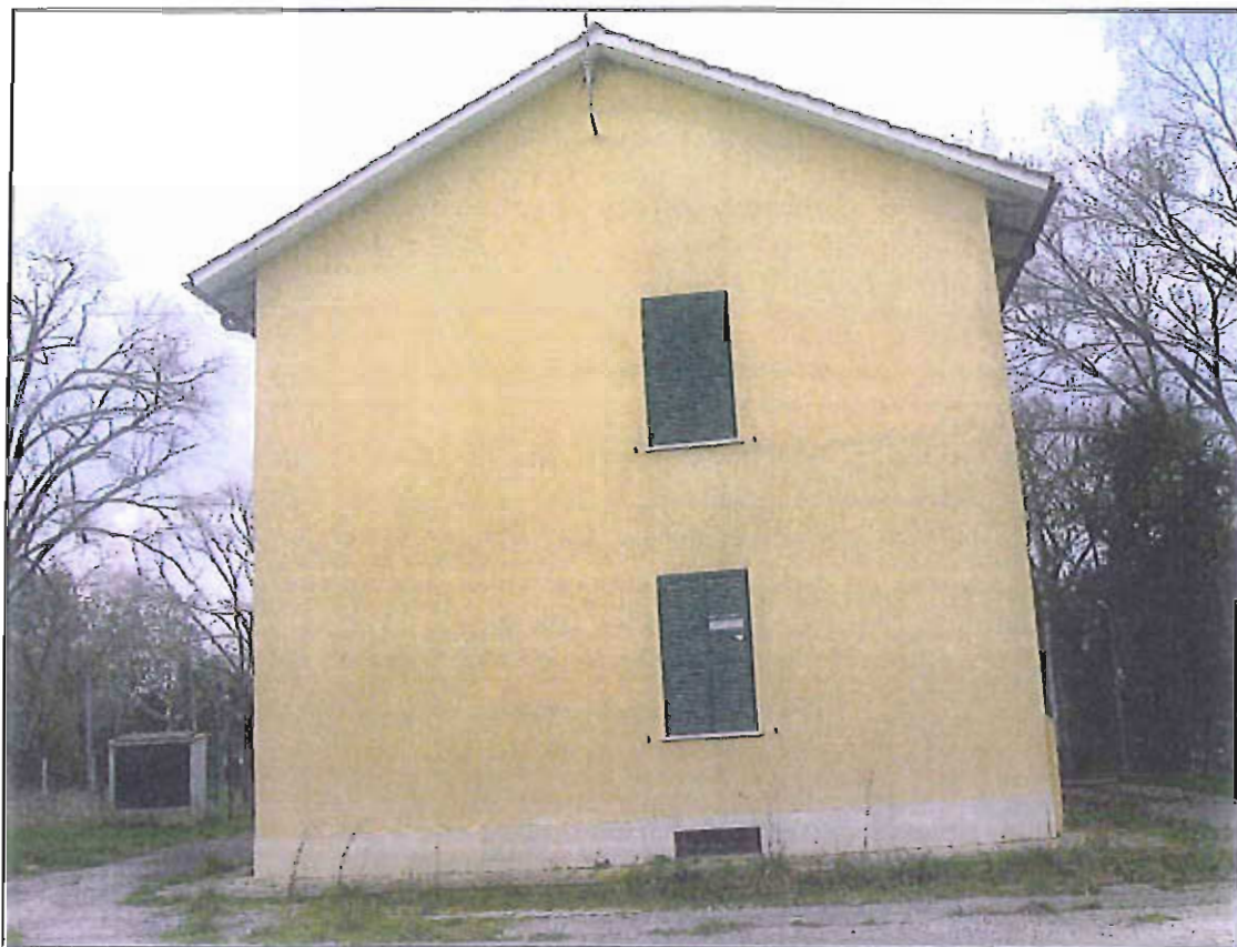
Figura 7 : Prospetto lato Est del fabbricato.
