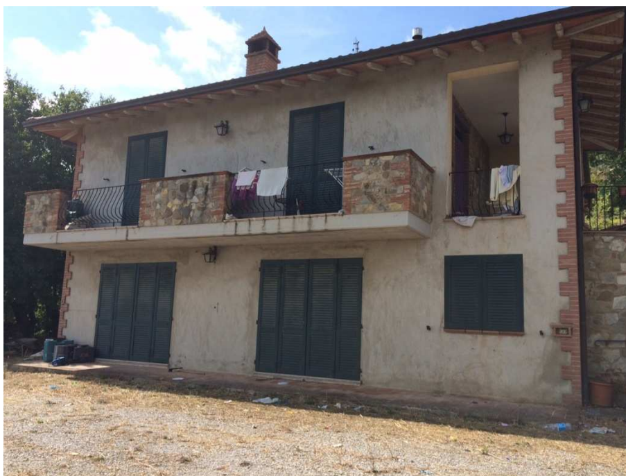
Foto n.34 Prospetto laterale sinistro
