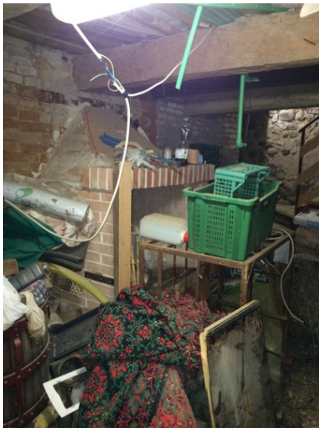
FOTO 3 - particolare camino nel vano principale
