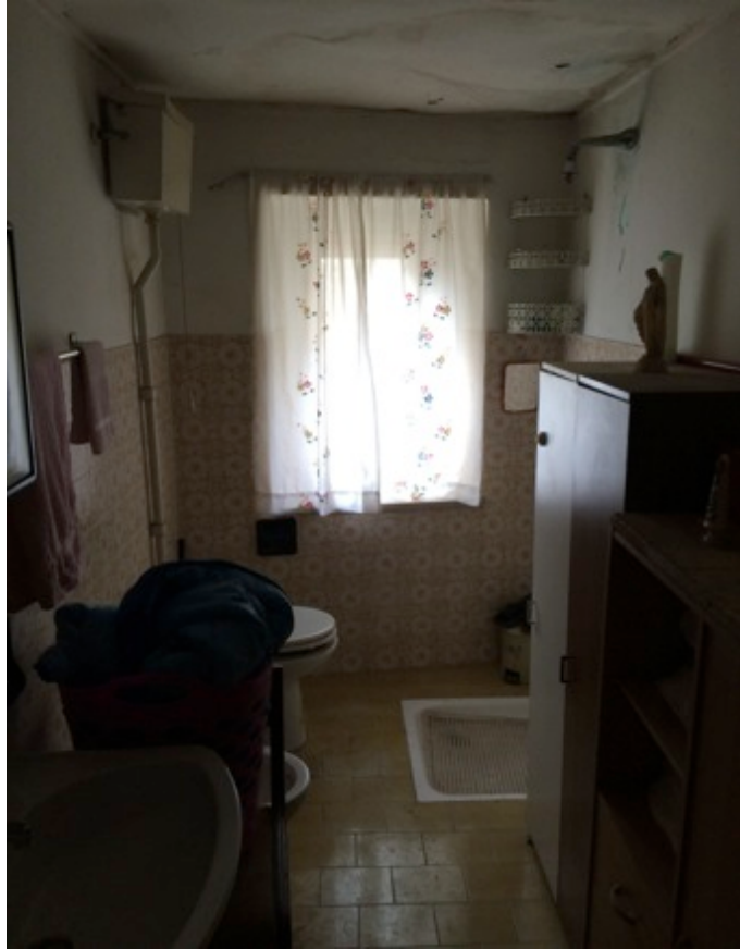
FOTO 9 - bagno al piano primo
