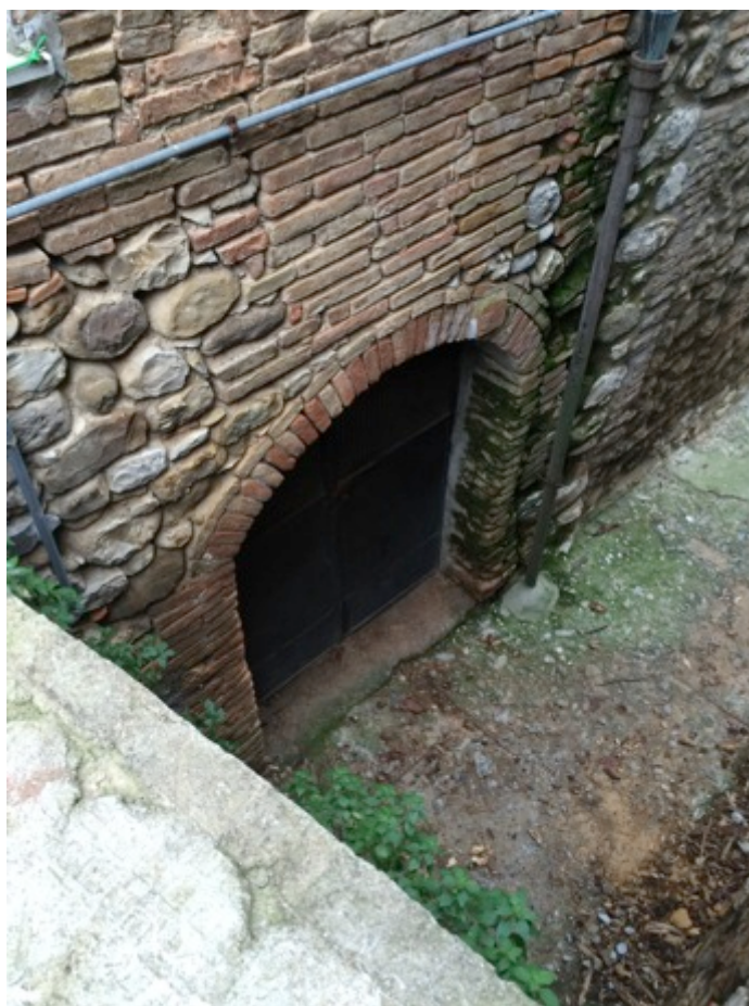
FOTO 1 - particolare ingresso sottostrada
