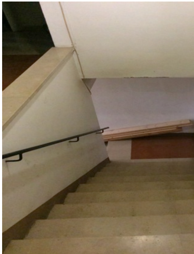
FOTO 10 - scala di collegamento piano terra-primo
