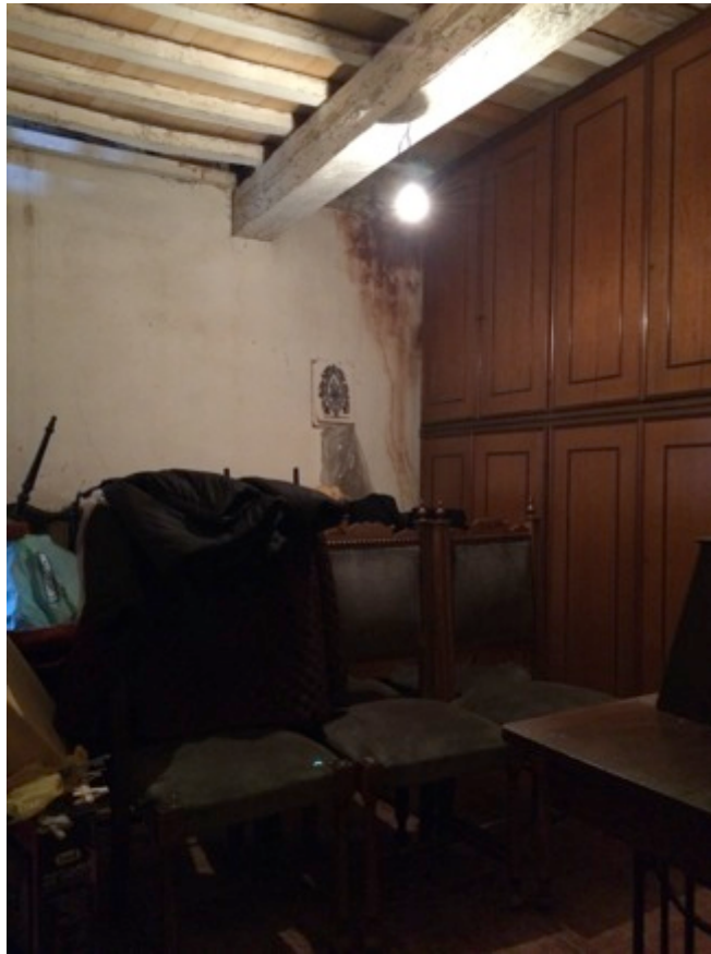
FOTO 7 - camera al piano primo
