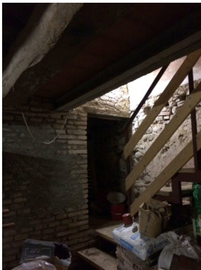
FOTO 4 - particolare scala interna di collegamento con il lotto 001
