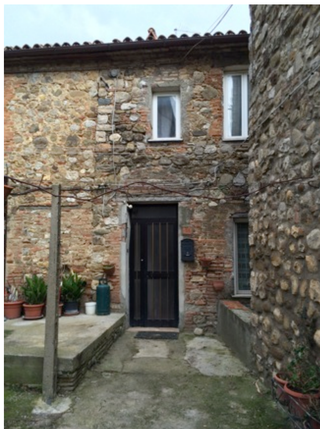
FOTO 2 - particolare dell'ingresso dalla strada comunale
