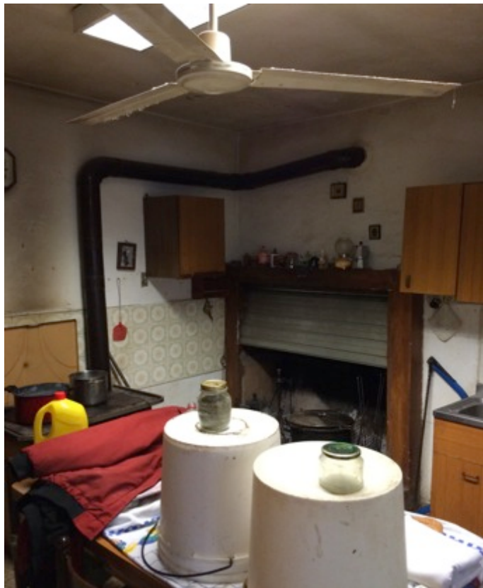
FOTO 4 - cucina al piano terra
