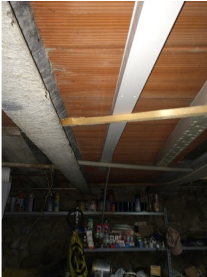
FOTO 6 - particolare solaio recente del soffitto (calpestio piano terreno)
