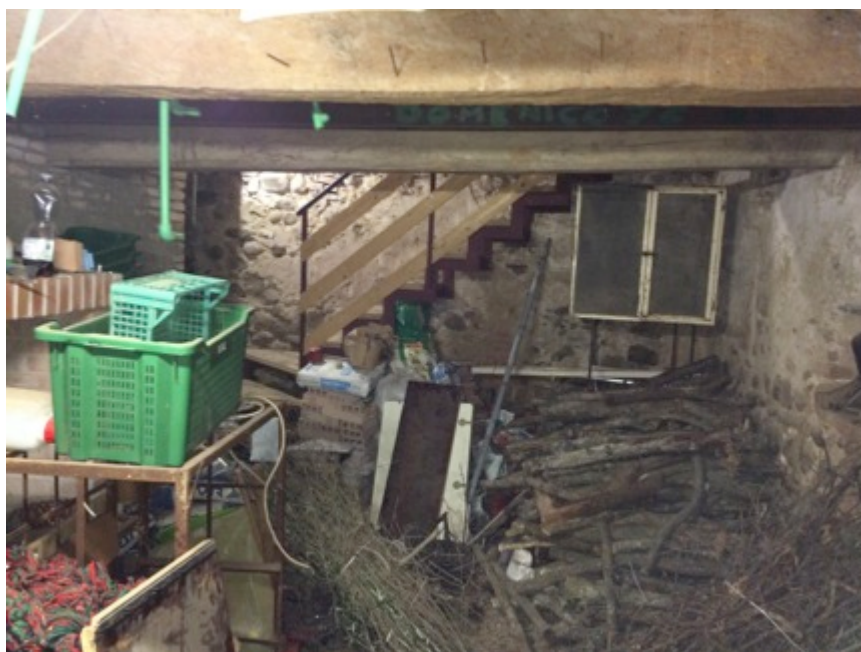
FOTO 2 - vano principale fronte ingresso
