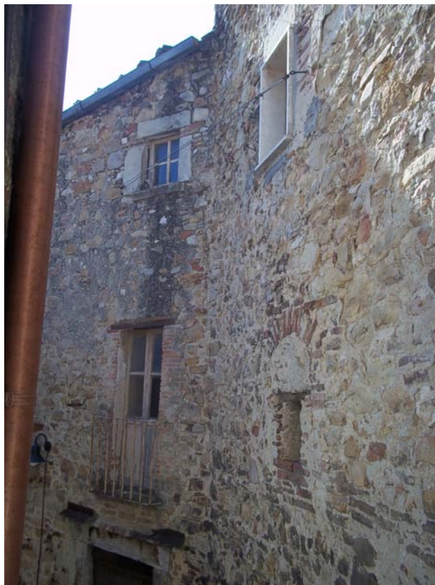
3 - Facciata lato posteriore – fronte est
