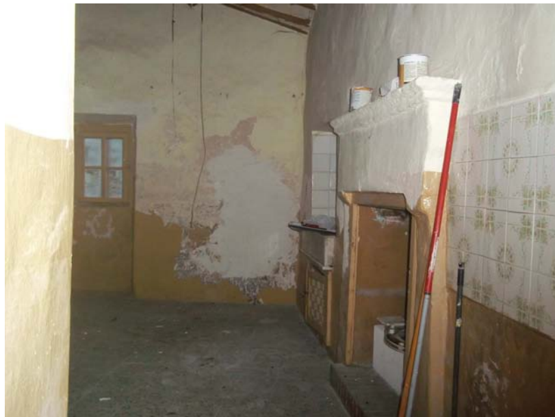
6 – P.Ila 126/2 – Locale cucina
