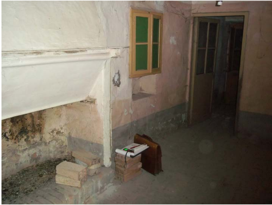
7 – P.Ila 126/1 – Locale ingresso-cucina
