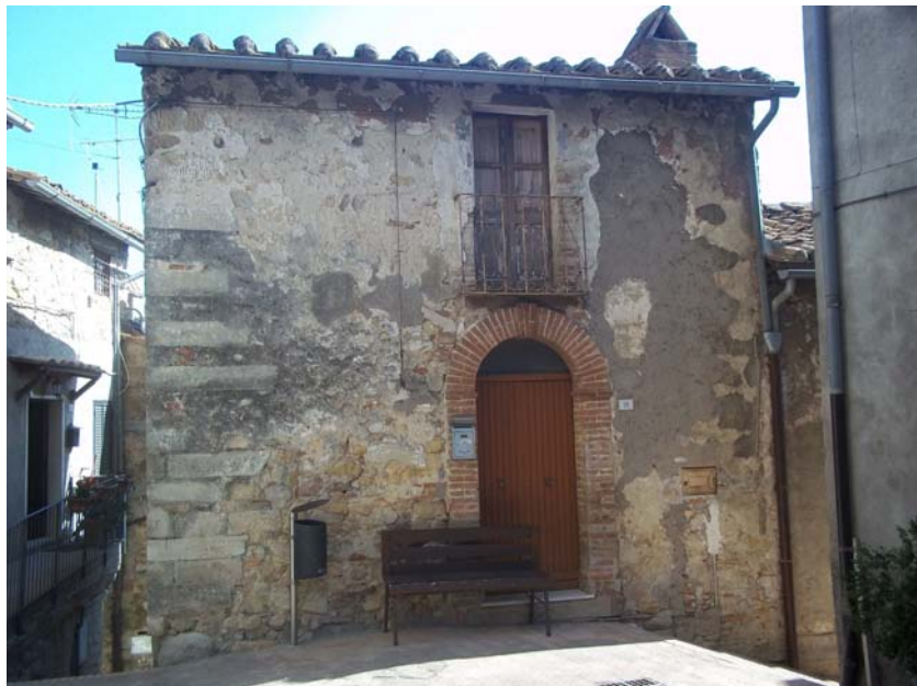
2 - Facciata lato ingresso - fronte ovest
