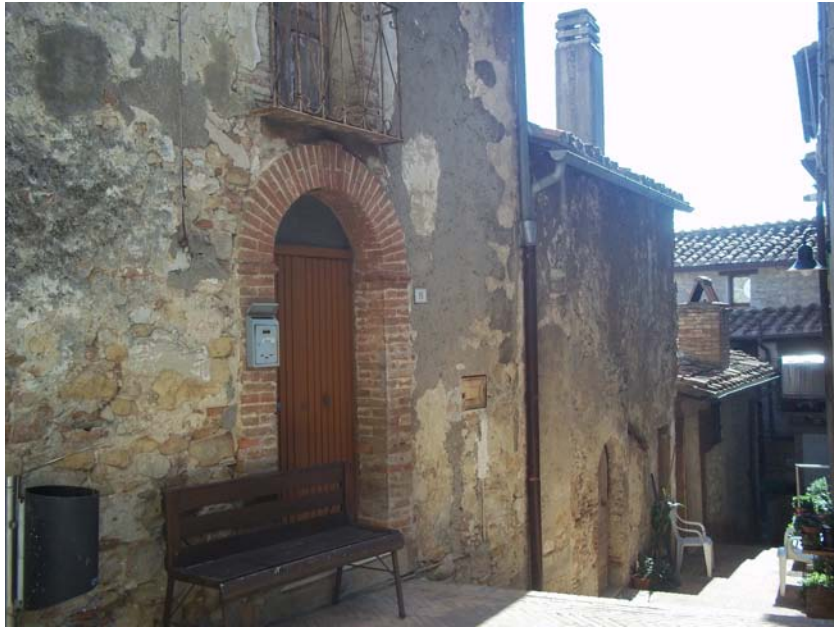
1 - Facciata lato ingresso - fronte ovest
