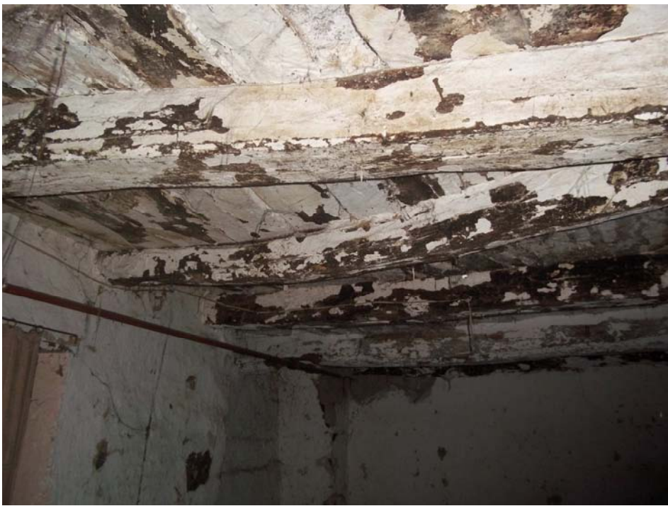
8 – P.Ila 126/1 (magazzino) – Solaio interpiano con P.Ila 126/2
