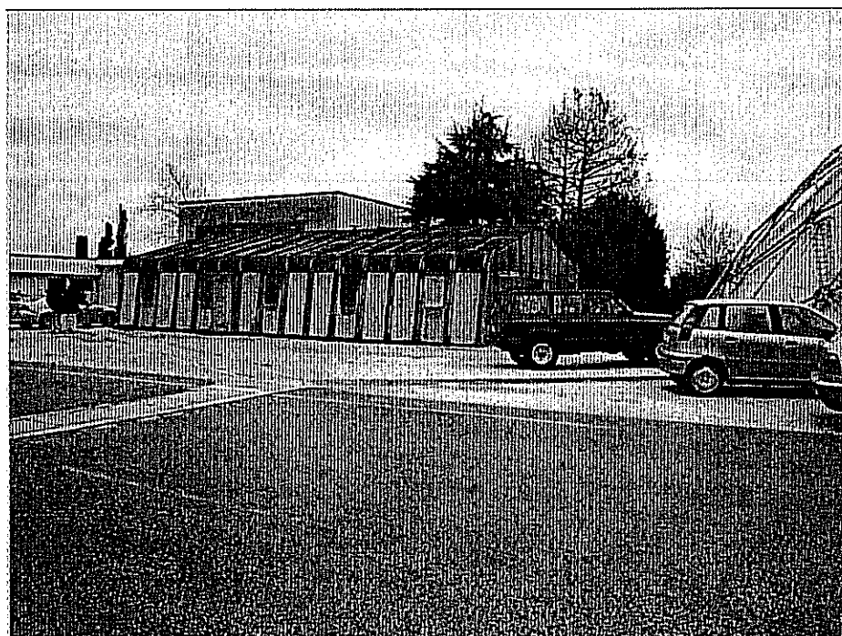
Fabbricato #T2: uffici prefabbricati
