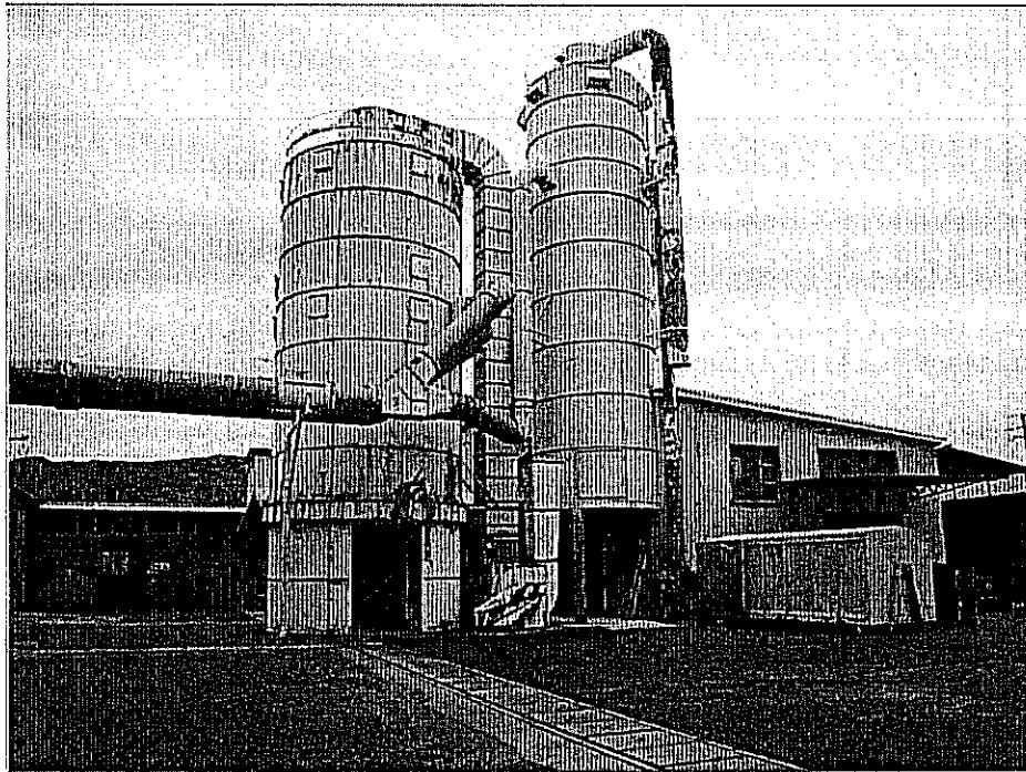
Fabbricato #04: deposito e silo stoccaggio segatura
