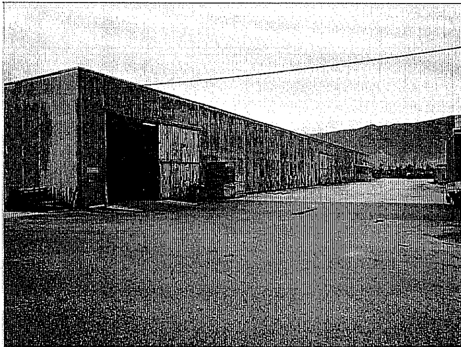
Fabbricato #03: lato Est
