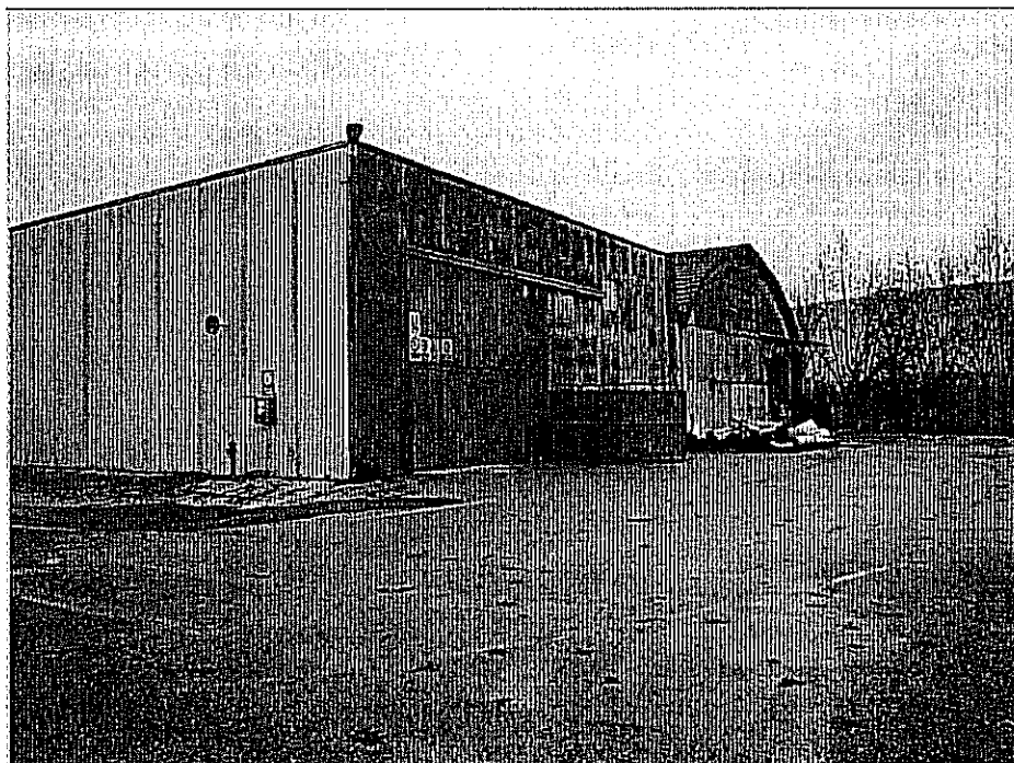
Fabbricato #02: corpo e lato Est
