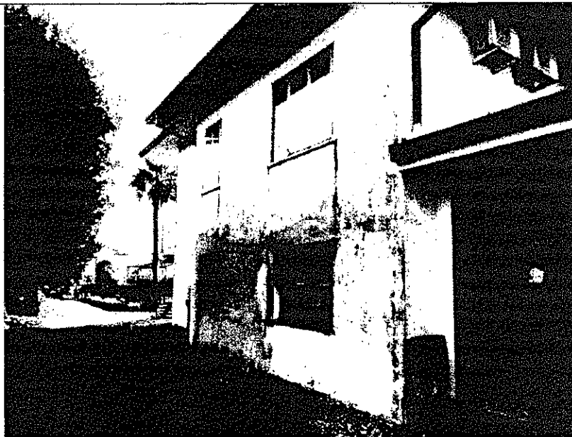
FOTO 8: vista prospetto est fabbricato residenziale
