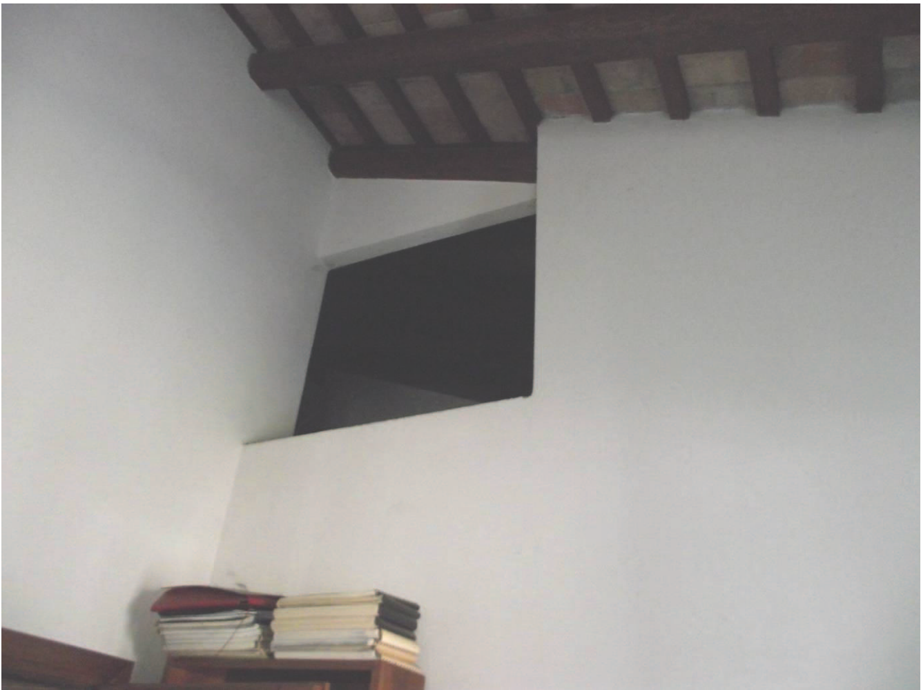
Foto 33 – piano primo – camera da letto 1: accesso al vano soffitta sopra il bagno della foto 32
