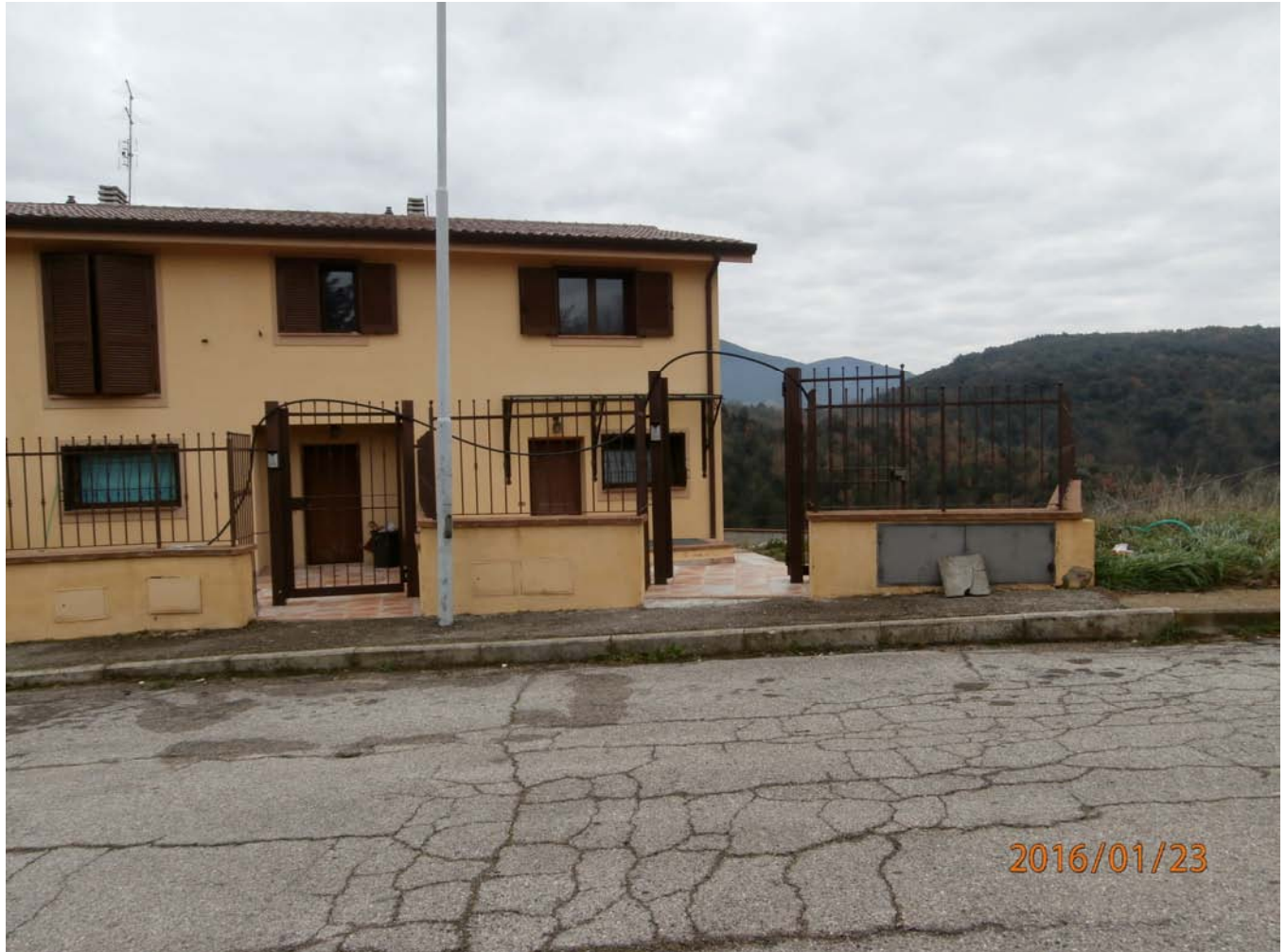
Foto n. 5. – LOTTO 1 – Ingresso pedonale da Via della Vite del Sub 6 e del Sub 12.
