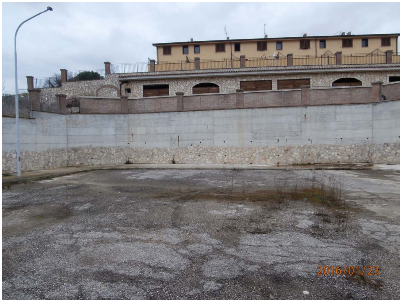
Foto n. 4. – Vista dal piazzale - parcheggio del livello sottostante le autorimesse; ( le quali non fanno parte del compendio pignorato perché ubicate in altra particella catastale ).
