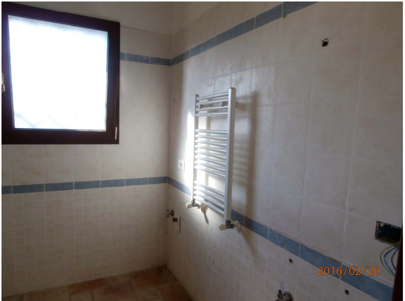
Foto n. 8. – LOTTO 1 – Piano Terra: bagno con doccia ( non completo di arredi ).
