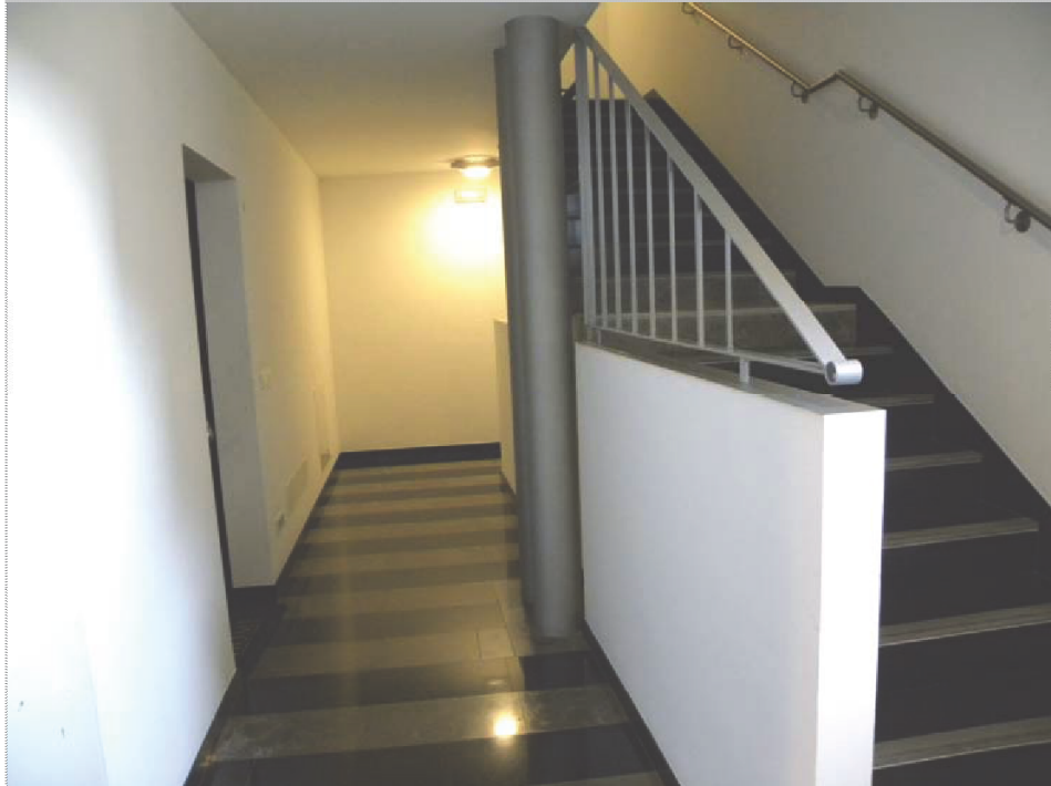
piazzetta Freschi [Condominio Borgo Cavallotti]- interni vano scala B
