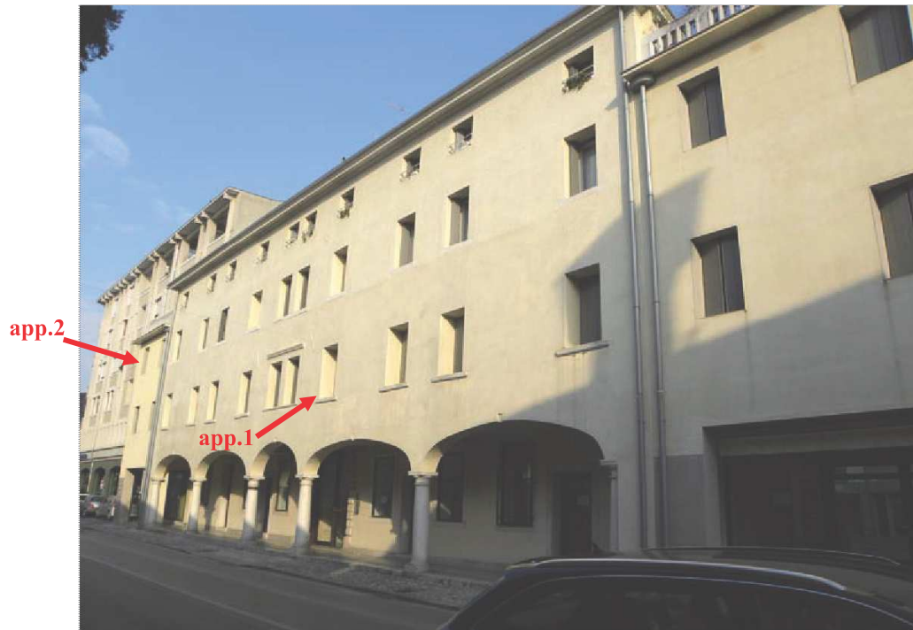
via Cavallotti □Palazzo Lorena□- vista fronte e ingresso principale (lato Ovest)
