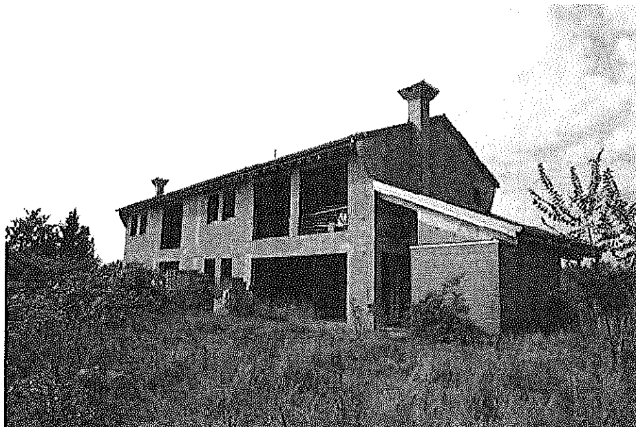
Foto 1: Immagine del fabbricato principale allo stato attuale
